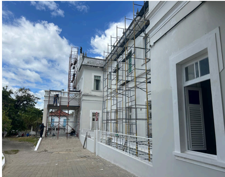
Pintura - Fachada frontal
