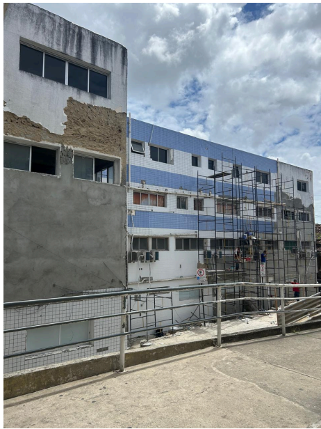
Revestimento - Prédio anexo
