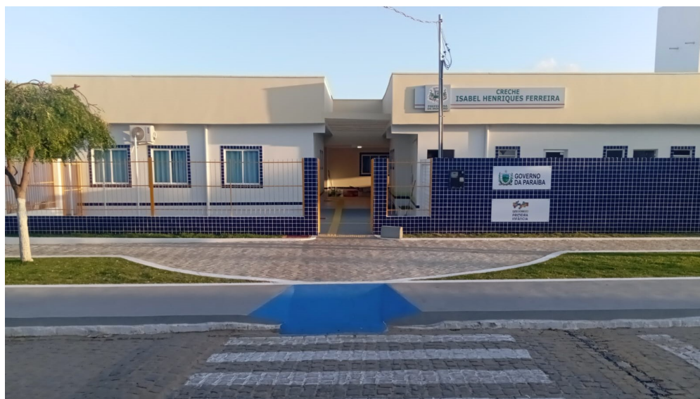
Figura 6: Creche concluída em Mogeiro-PB.
