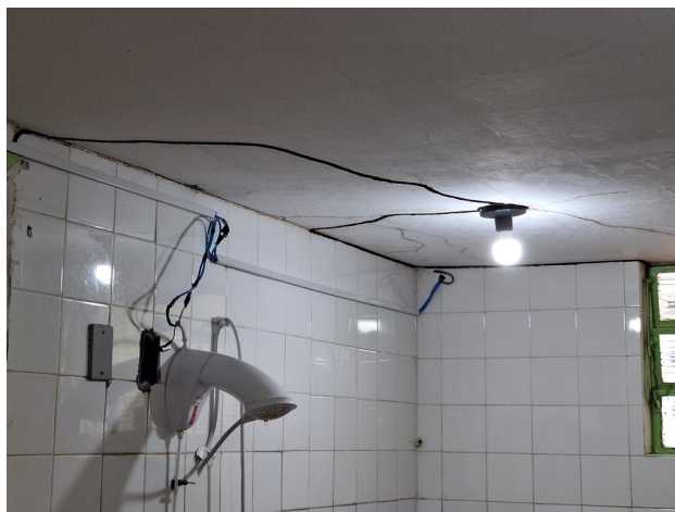
(b) Instalação elétrica irregular
