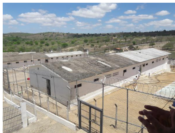
Isolamentos internos – Penit. Raimundo Asfora
