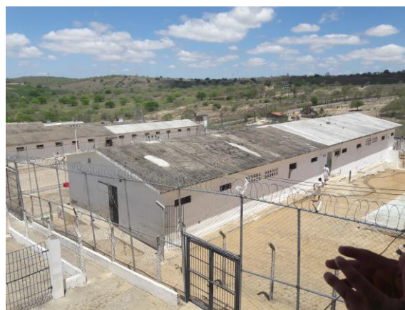
Isolamentos internos – Penit. Raimundo Asfora
