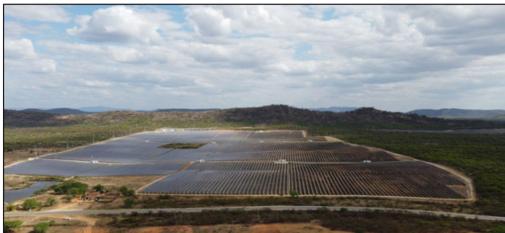
REGISTRO FOTOGRÁFICO 04 - VISÃO PANORÂMICA DA USINAS FOTOVOLTAICAS EM MALTA (OUT 2022)
