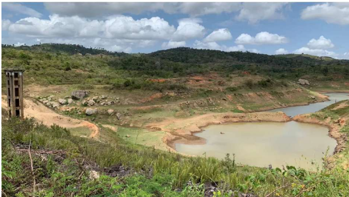
Figura 28: Visão panorâmica do reservatório Canafístula II em setembro de 2021.
