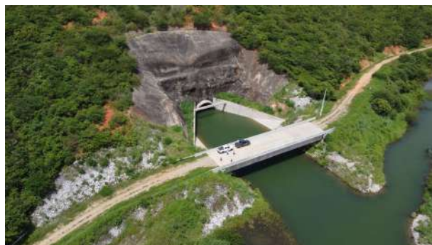
(a) Chegada do Túnel Cuncas II á barragem de Caiçara.
