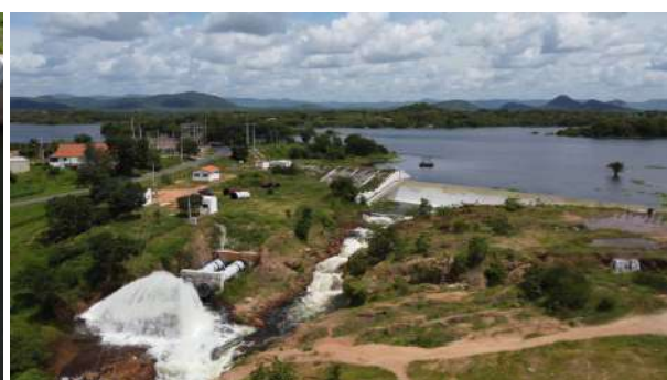
(f) Reservatório de São Gonçalo vertendo água pelo sangradouro e válvula de dispersão aberta.
