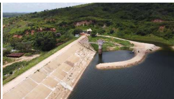
(d) Reservatório de Engenheiro Avidos. Execução de ensecadeira para instalação de válvula de dispersão.
