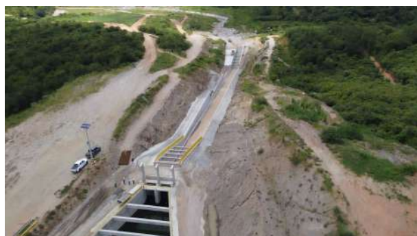
(c) Descida rápida entre os Reservatórios Caiçara e Engenheiro Avidos (comporta fechada).
