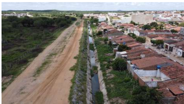
(c) Canal de águas pluviais com águas servidas ao lado da galeria (d) Portal de entrega (direita) e canal de águas pluviais com águas servidas com as águas do PISF.
