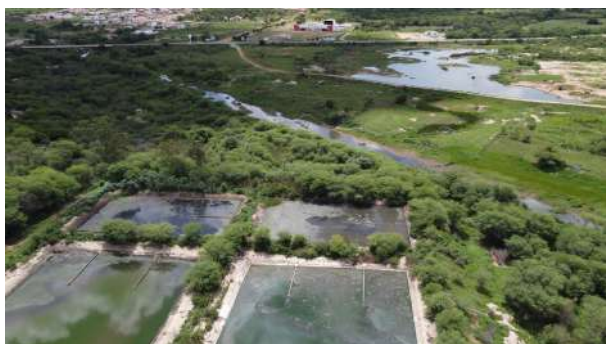
(a) Lagos de tratamento próximas a APP do Rio Paraíba.
