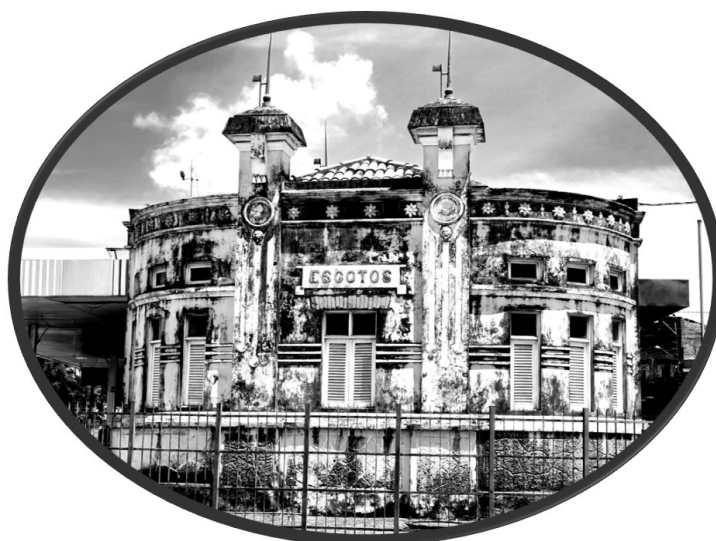
Estação Elevatória de Esgotos do Varadouro (João Pessoa, PB) 2
