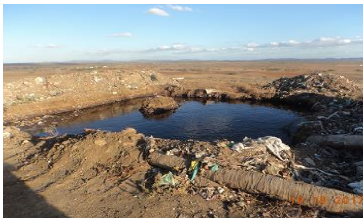
Aterro Sanitário da Ecosolo, em Campina Grande - Concentração de chorume recirculado sobre a célula.
