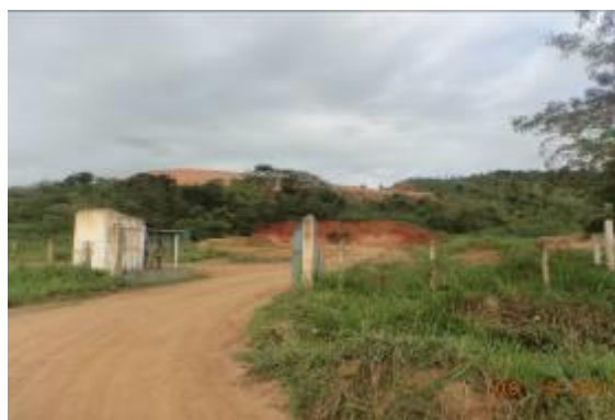
Entrada do local de disposição final de lixo no município de Alagoa Grande (ausência de balança)
