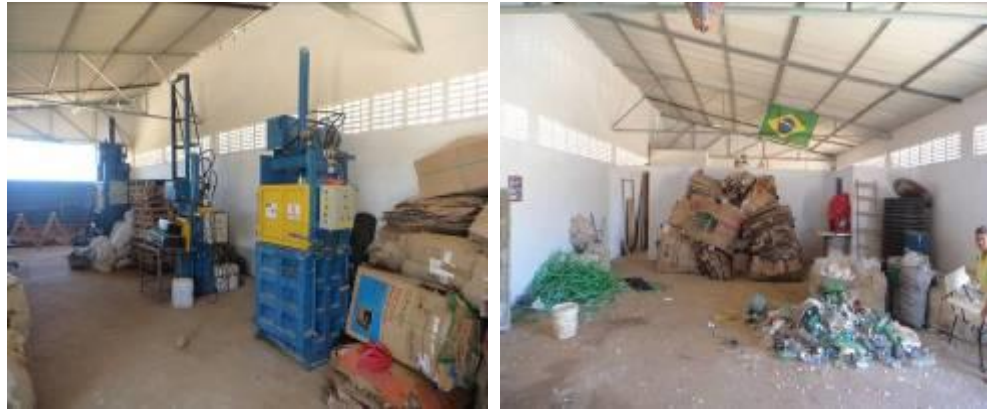
Patos - Associação de Catadores de Materiais Recicláveis/Galpão de estocagem e manuseio - equipamentos sem funcionamento e ausência de projeto elétrico
