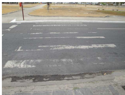
Foto 14 – Av. João Cândio
