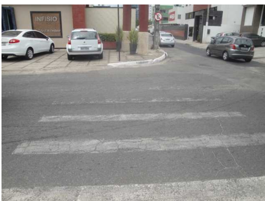
Foto 15 – Av. João Cândio
