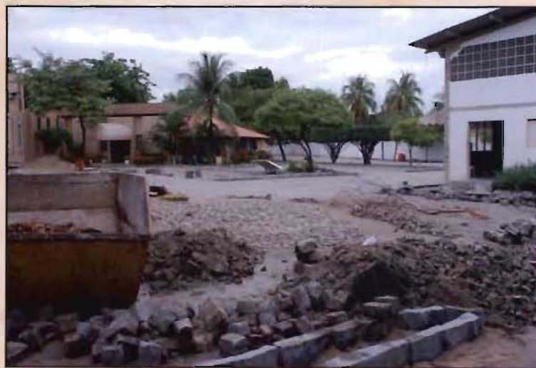
Pátio interno do TCE é preparado para o estacionamento
