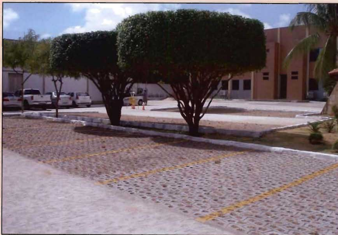
Depois de realizados todos os serviços para construção de galerias, a área do estacionamento interno foi pavimentada ecologicamente e feitos os complementos de paisagismo e jardinagem
