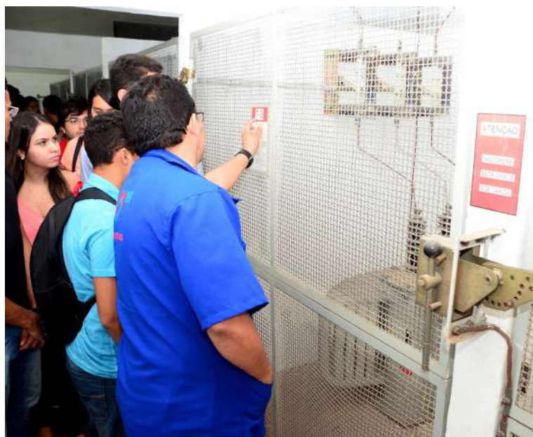
Os universitários conheceram a sala de transformadores, e tomaram conhecimento de detalhes técnicos e benefícios do sistema fotovoltaico durante palestra do engenheiro José Carlos Tormim, representante da empresa MTEC Comércio e Serviço de Instalações Técnicas, que executou do projeto.
